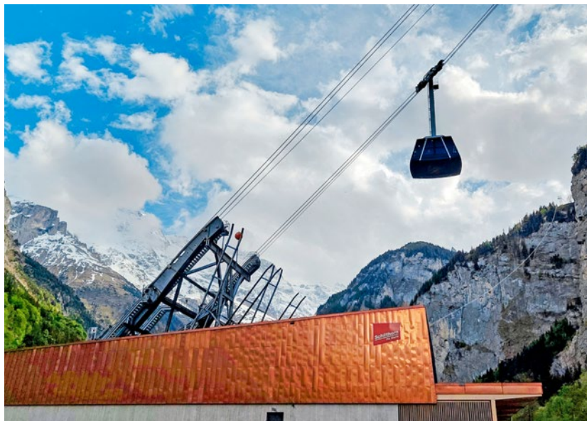
Le téléphérique du Schilthorn qui mène à Mürren est le plus raide du monde. Il est tellement raide que les cabines quittent en quelque sorte la station inférieure par le toit. Photo Dölf Barben
