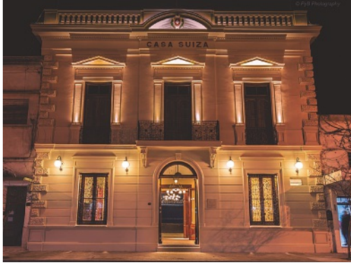
Fachada restaurada de la Casa Suiza de Baradero
