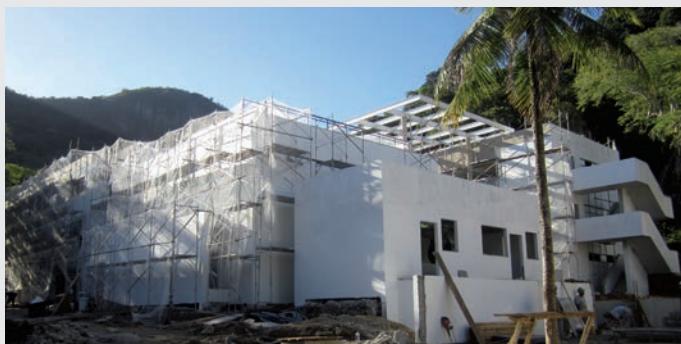
Nova unidade em construção
