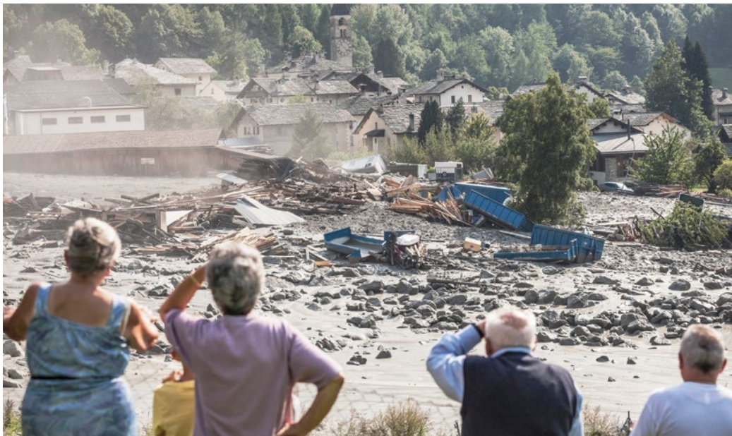
Les habitants de Bondo constatent les dégâts provoqués par la boue, les débris et les éboulis.
